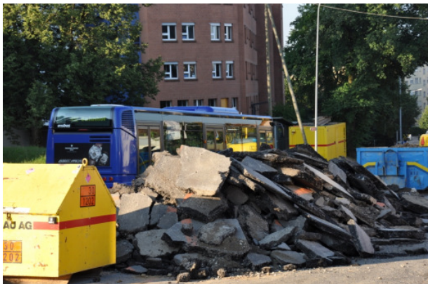
Der VZO-Bus schlängelt sich durch die Baustelle beim Spital Uster.
